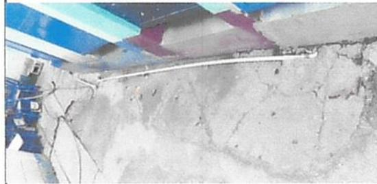
Foto 4: Introducción de agua entubada a los servicios sanitarios el tinaco ya se tiene tuberia no tiene aun.
