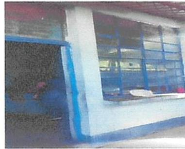
Foto 2: se observa que la ventana esta en mal estado ya no corre la ventana movible tiene vidrios quebrados se encierra mucho el humo al cocinar tambien la entrada a la cocina esta rajada la torta.
