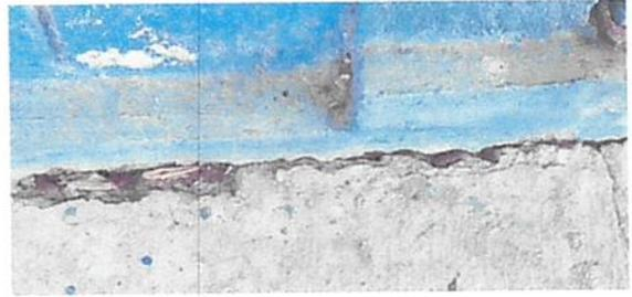
Foto 2: esta es area de la cocina y aula de primero del motulo 1 se deterioro necesita remozar el concreto porque se separo de las paredes.
