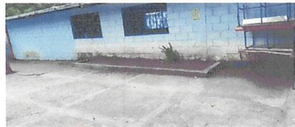
Foto 6: en este modulo se observa la marca del agua donde se ha filtrado a las tres aulas siendo necesari la banqueta para evitar la filtración del agua.
